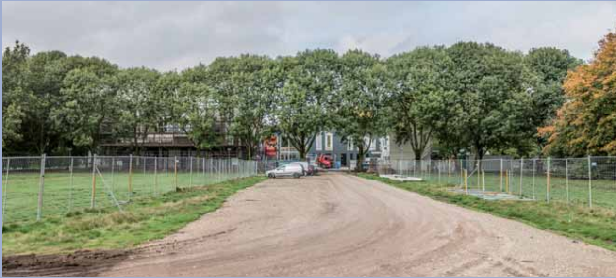
Blik op het gebouw vanaf de toekomstige parkeerplaats / promenade (zuidzijde)
