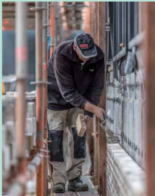
De muren van MFA Midden worden opgetrokken met traditioneel metselwerk
